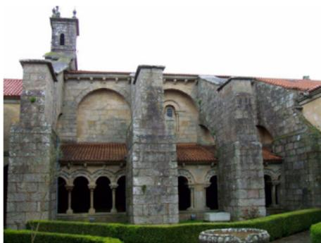
Llama la atención la acusada inclinación de los pilares de sus naves, cuya causa parece deberse a la coincidencia de diferentes factores relacionados tanto con deficiencias en la construcción como con la naturaleza pantanosa del terreno.
